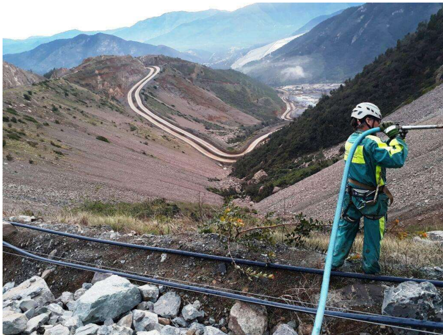
Hidrosiembra con semillas del bosque esclerófilo, en Mina el Soldado
